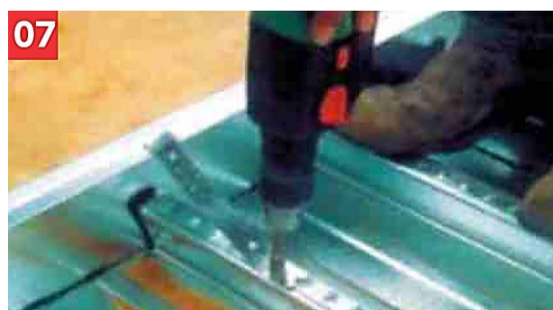
7 Fix steel edge form
